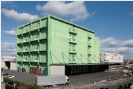
岡山流通センター
